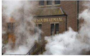
Het Ir. D.F. Woudagemaal in Lemmer, Friesland
